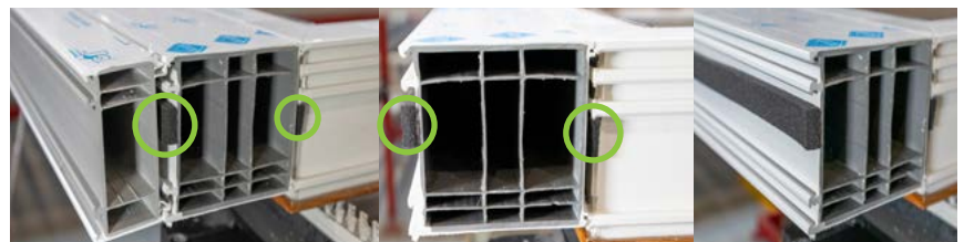
RUBAN D'EXPANSION POUR LES PROFILS D'EXTENSION INSTALLÉS PENDANT LA PRODUCTION
