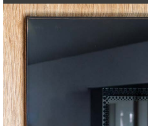
DETAL OD ZEWNĄTRZ
