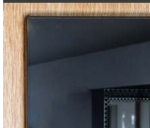
DETAL OD ZEWNĄTRZ
